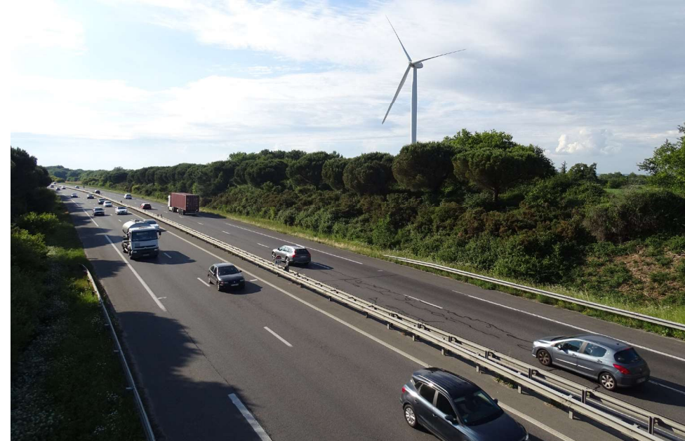
▲ RN 165 à hauteur de CAMPBON ©addrn
