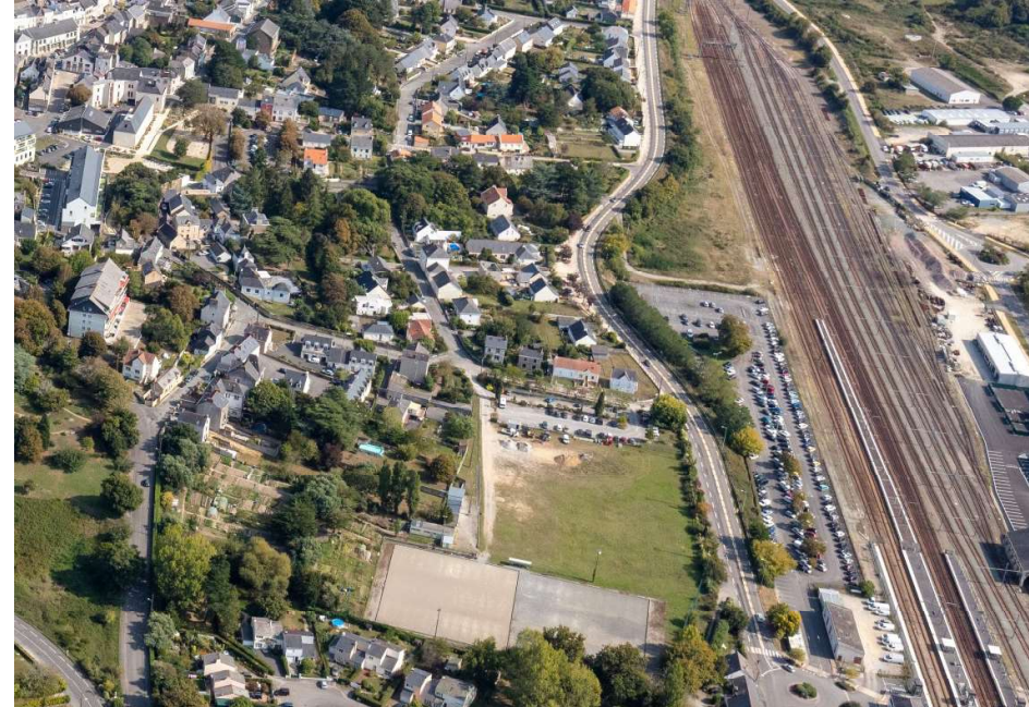
▲ Vue aérienne de la Gare de Savenay ©ArnaudDréan
