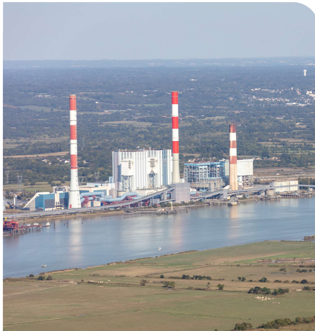
PHOTO - Centrale de Cordemais Source : ©ArnaudDréan
